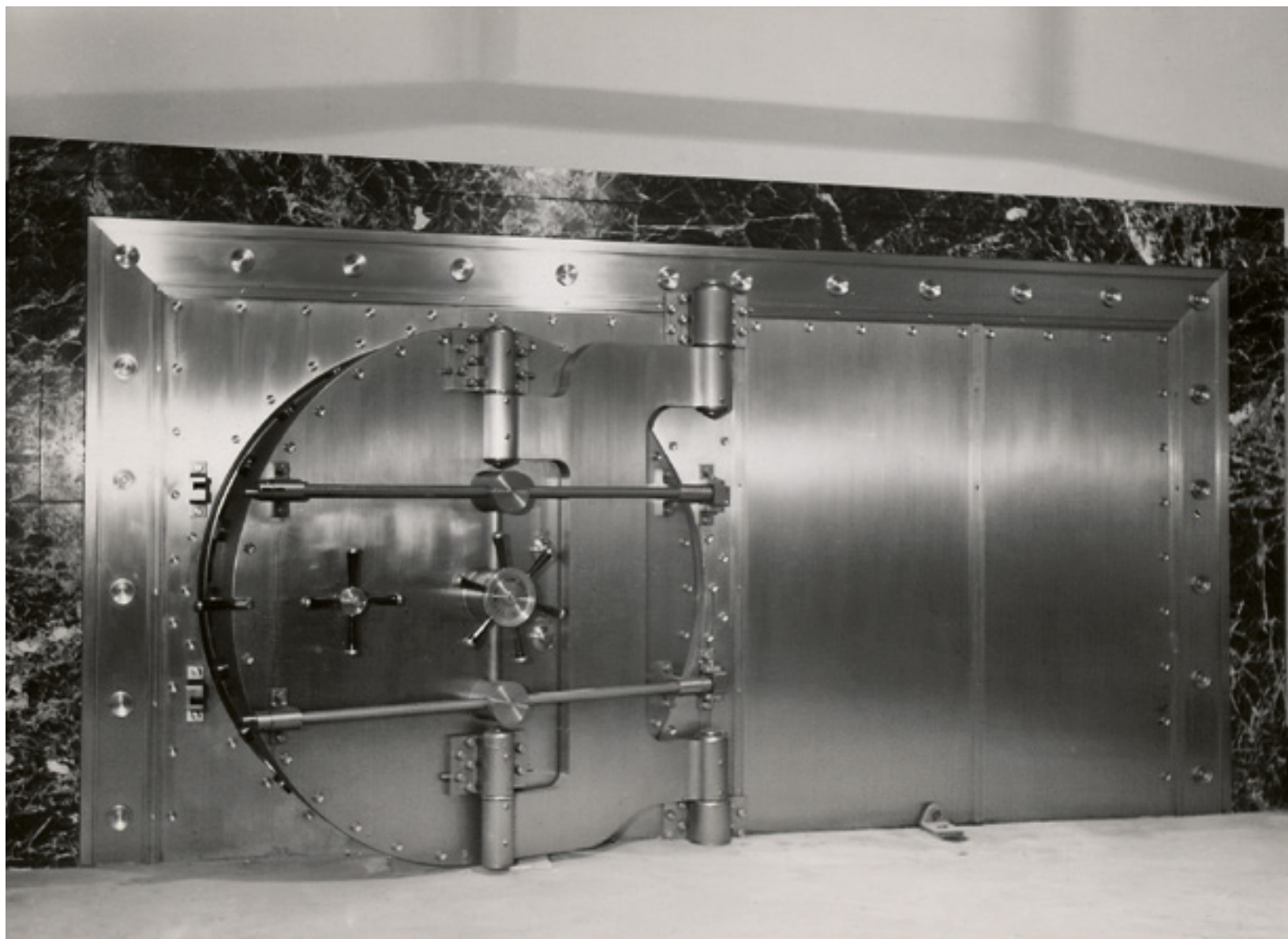
Madrid. Puerta blindada de ingreso al pozo n.º 1 de la caja subterránea del Banco de España. 1936. Fotógrafo: Antonio de Zárraga. Positivo. Plata en gelatina. N.º inv. 1053.
