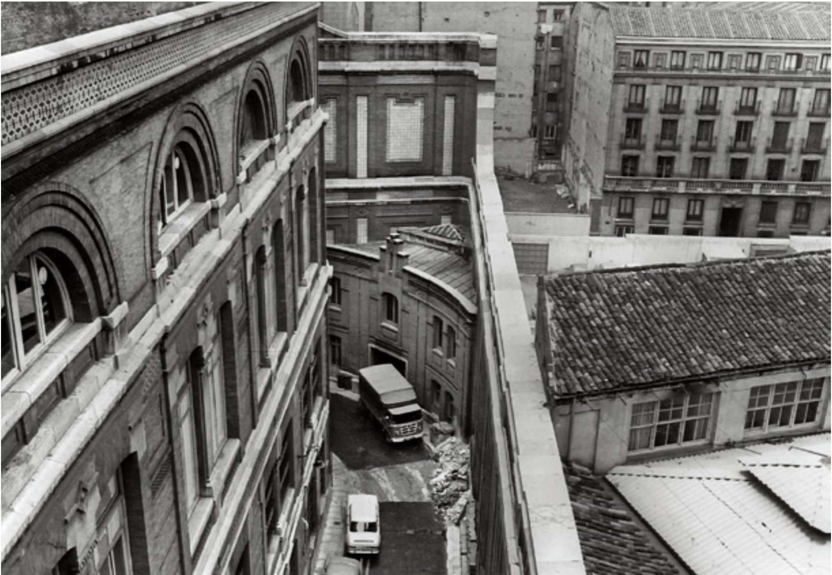
Madrid. Fachada interior del edificio del Banco de España y vista del callejón perimetral de aislamiento antes de la demolición del muro para la ampliación del edificio en las calles de Los Madrazo y Marqués de Cubas. Ca. 1969. Fotógrafo: desconocido. Positivo. Plata en gelatina. N.º inv. 9377.
