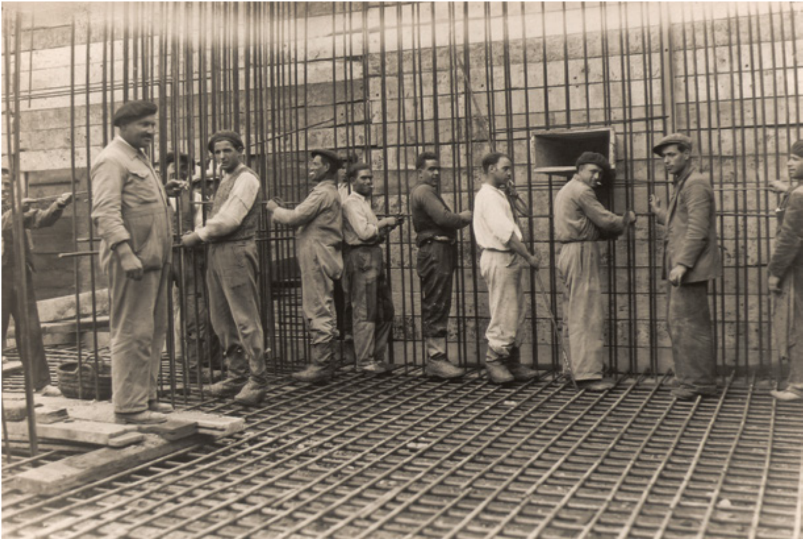
Sucursal de Teruel. Construcción de los forjados de la caja fuerte (plaza de Emilio Castelar, luego de San Juan, sede entre 1936 y 2002, obra del arquitecto Juan de Zavala Lafora). 1934. Fotógrafo: desconocido. Positivo. Plata en gelatina. N.º inv. 13752.
