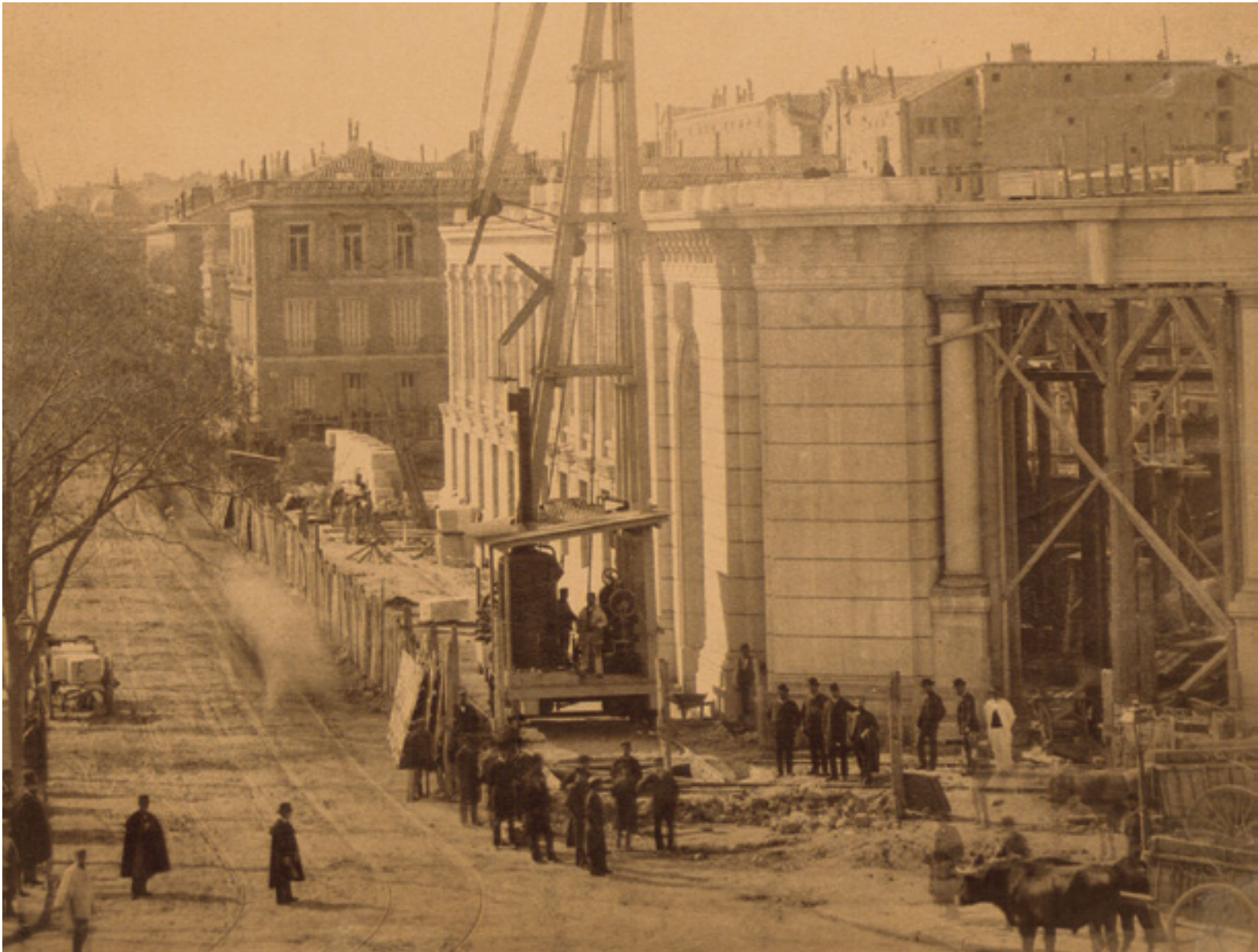
Madrid. Grúa de vapor subiendo materiales al edificio del Banco de España en construcción. Vista de la fachada del paseo del Prado y del chafalán de Cibeles. Ca. 1886. Fotógrafo: J. Laurent y Cía. Positivo. Papel a la albúmina. N.º inv. 2327.
