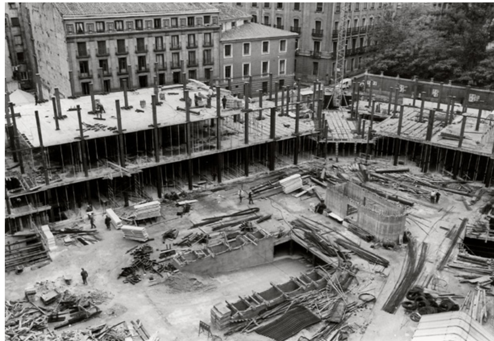
Madrid. Obras de ampliación del edificio del Banco de España en las calles de Los Madrazo y Marqués de Cubas. Construcción de las plantas sobre rasante. 1971. Fotógrafo: desconocido. Positivo. Plata en gelatina. N.º inv. 9629.
