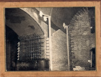
Falsa bóveda y tabique aislante de la Cámara Reservada en construcción.
