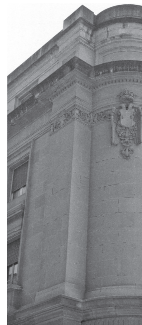
Detalle de la fachada.
