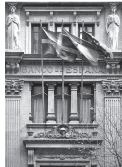
Detalle de la fachada. Fatxadaren xehetasuna.
