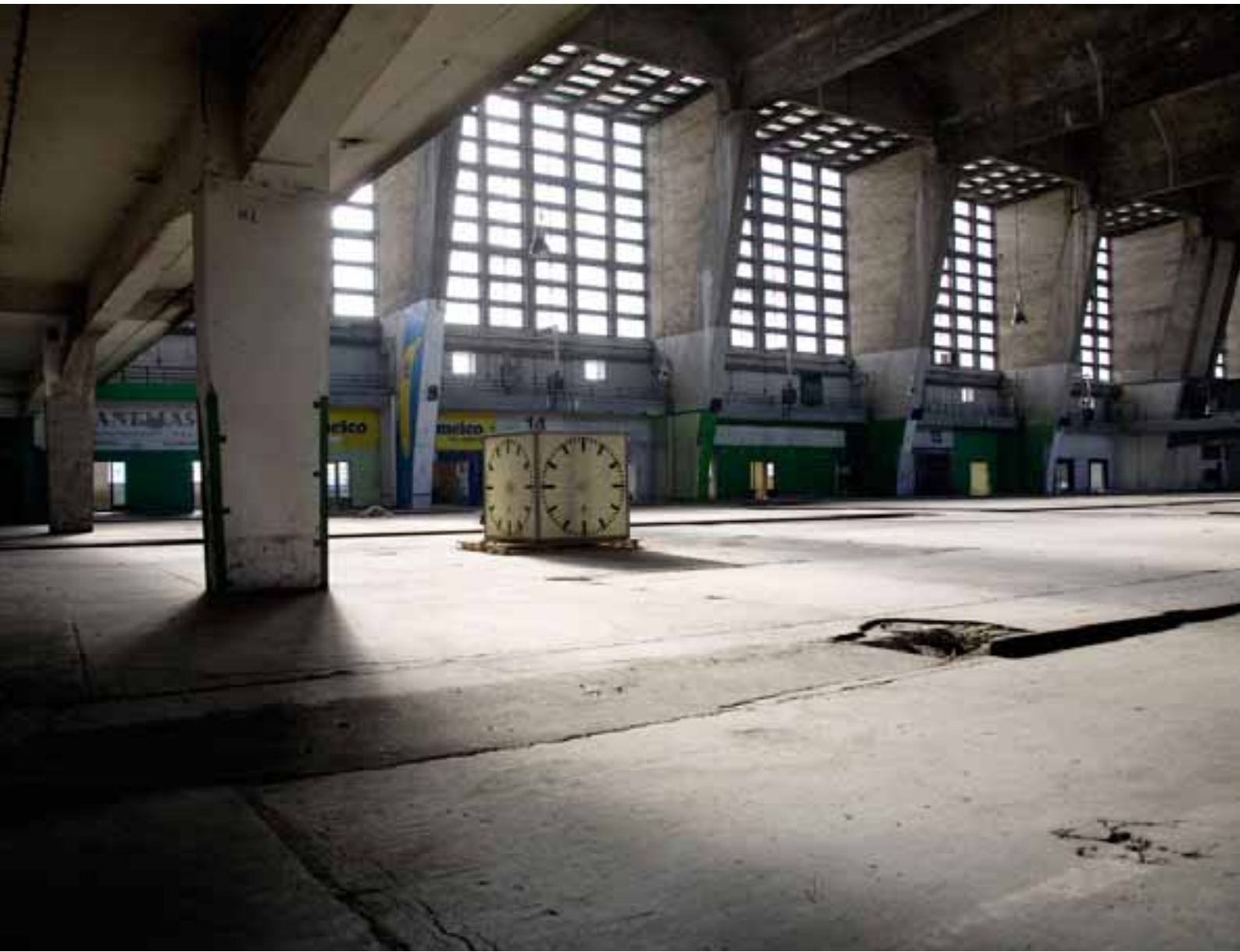
Vista del interior del antiguo Grossmarkthalle, un edificio protegido (febrero de 2008). El Grossmarkthalle, diseñado por Martín Elsaesser, era la estructura diáfana de hormigón armado más grande del mundo cuando se terminó de construir en 1928.
