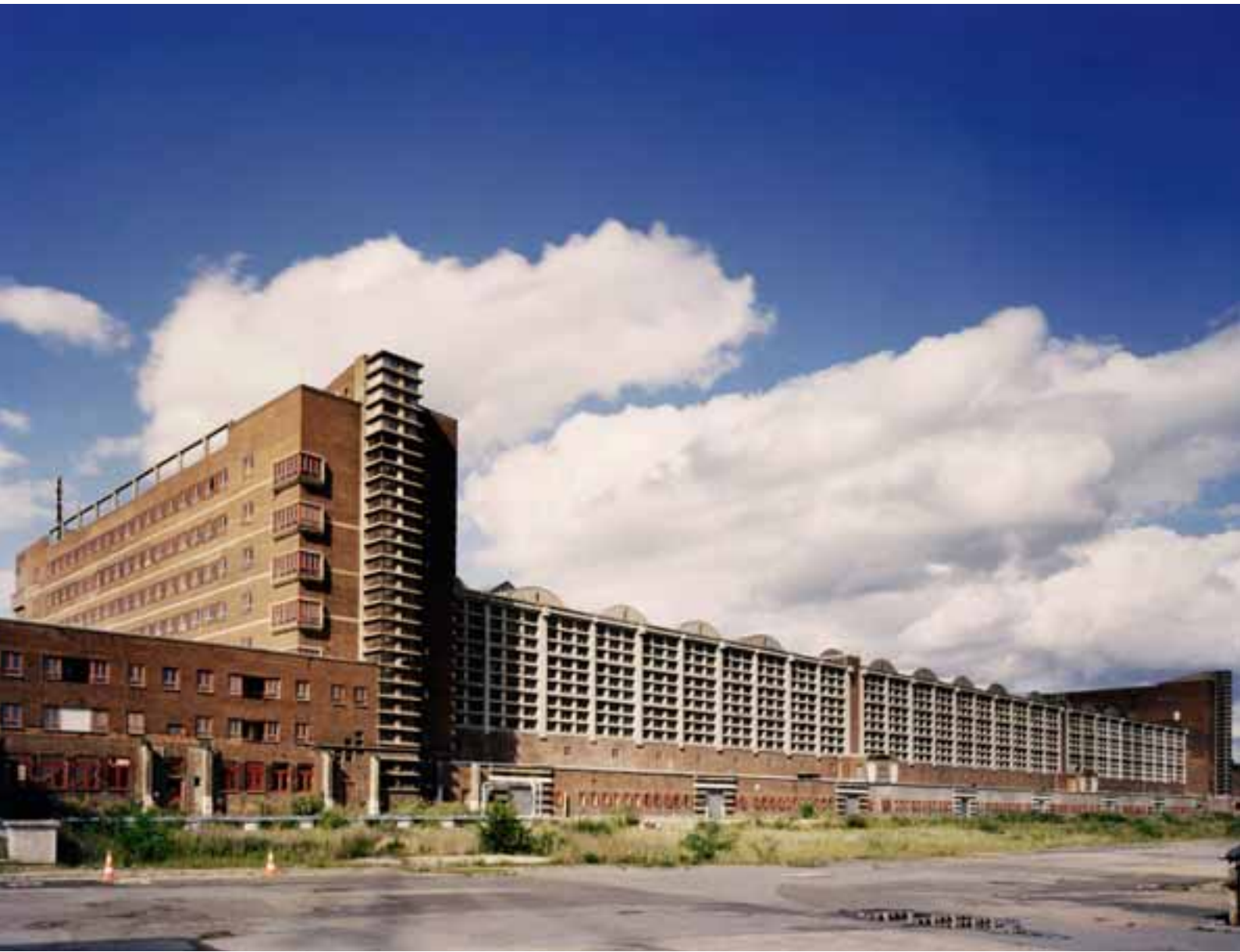
Vista del Grossmarkthalle desde el sur (2006).
