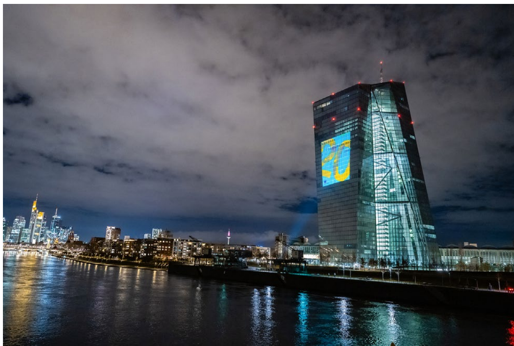
Iluminación del edificio de la sede del Banco Central Europeo con motivo del 20.º aniversario del euro.
