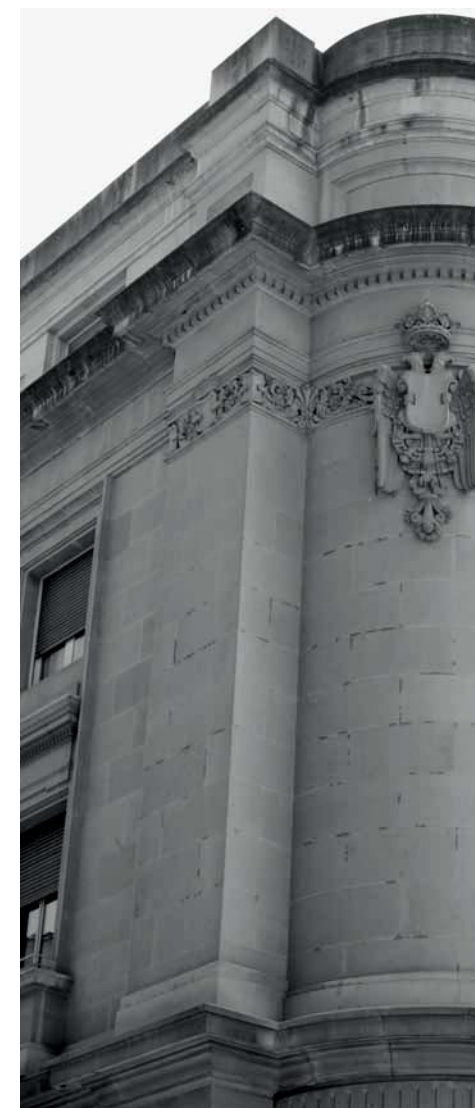
Detalle de la fachada.
