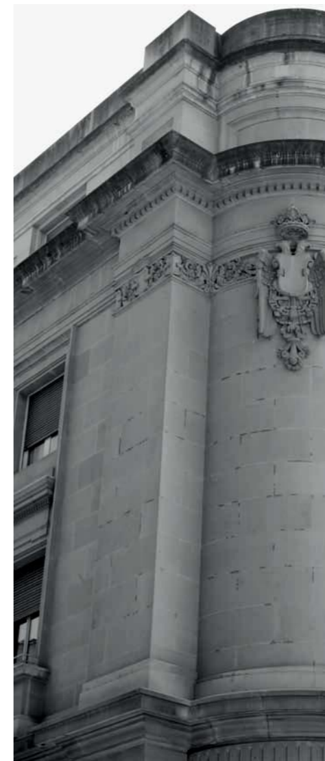
Detalle de la fachada.
