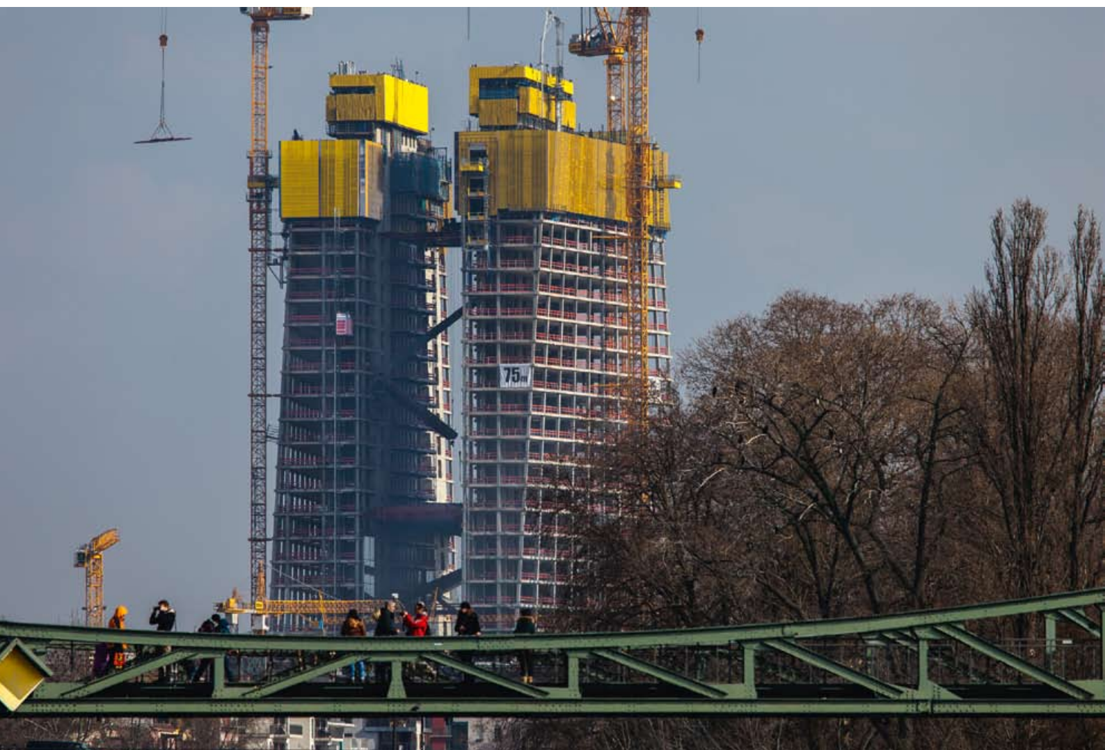
En 2012, la nueva sede del BCE empezó a conformarse como nuevo elemento visible del perfil de la ciudad de Fráncfort. El rascacielos se levantó con más rapidez de lo previsto, a un ritmo aproximado de una planta cada seis días.
