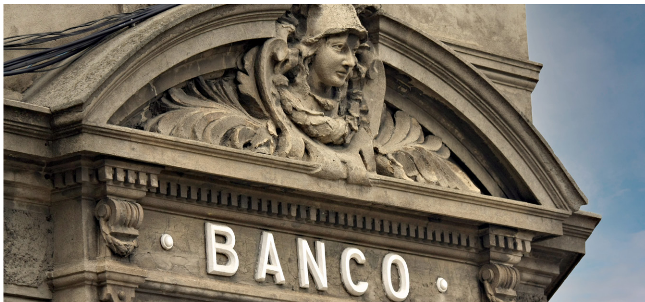
Edificio bancario en Punta Arenas, Chile.
