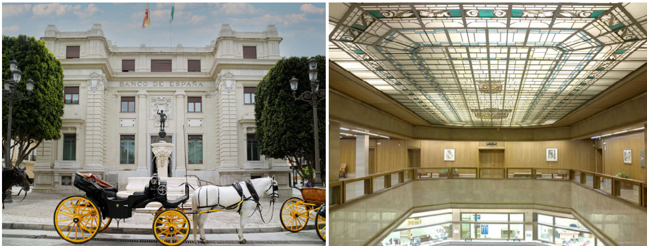
Fachada principal de la sucursal de Sevilla (izquierda). Vidriera cenital del Patio de Operaciones de la sucursal de Zaragoza (derecha).
