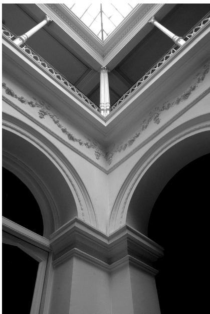
Detalle del patio interior de la sede del CEMFI.
