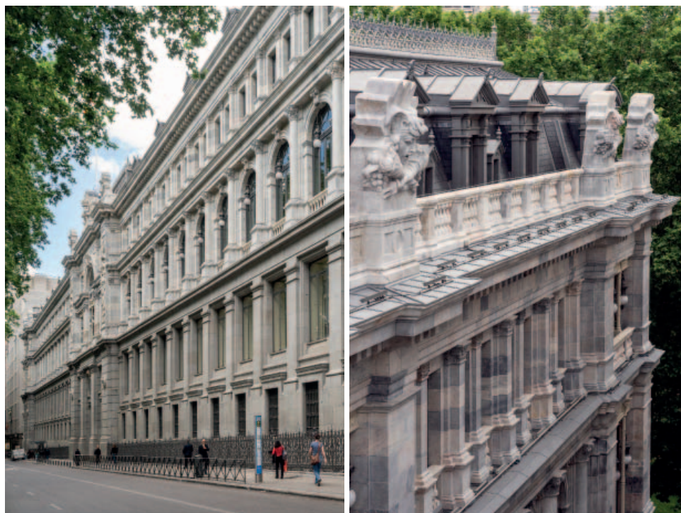
Fachadas del paseo del Prado vista desde Cibeles (izquierda) y de la calle de Los Madrazo (derecha), después de los trabajos de restauración y de limpieza. Sede central del Banco de España.
