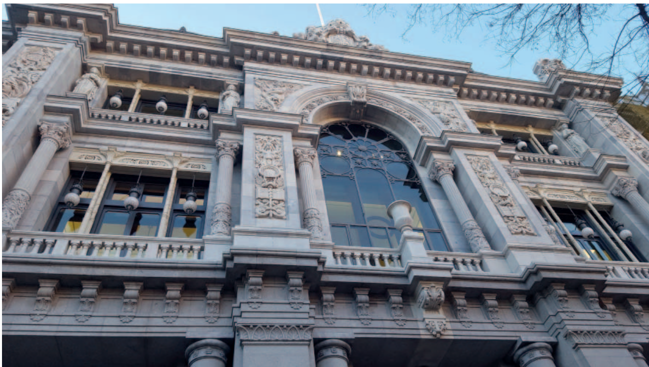
Fachada del edificio de Cibeles después de los trabajos de restauración y limpieza.
