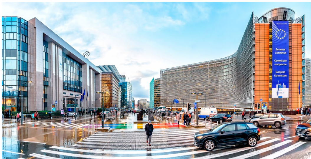
Vista panorámica del edificio Berlaymont, sede de la Comisión Europea, en Bruselas.
