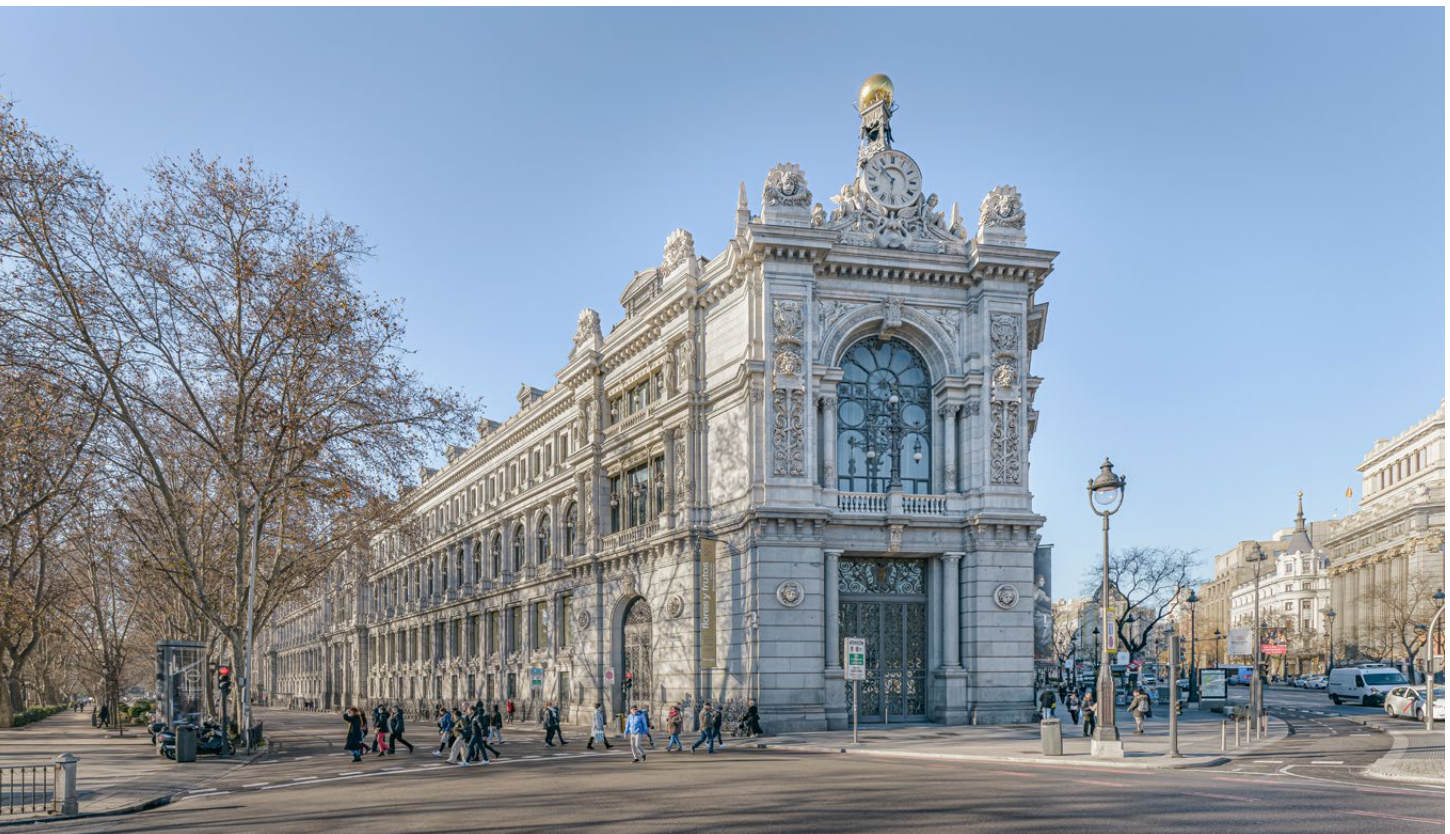
Vista desde Cibeles de las fachadas principal y del paseo del Prado de la sede central del Banco de España.
