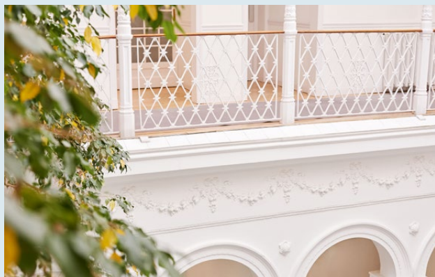
Detalle del patio interior de la sede del CEMFI.
