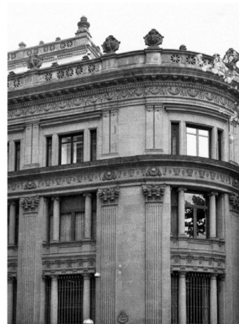
Fachada lateral del edificio. Eraikinaren alboko fatxada.
